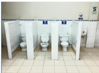
REMODELACIÓN DE CAMBIADOR Y LAVADO PARA AULA AMARILLA
