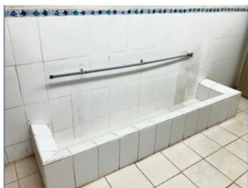
CAMBIO DE TUBERÍA DE LA RED DE AGUA
